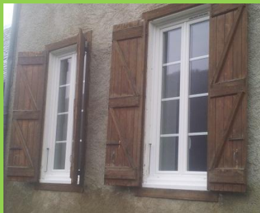
Les menuiseries des gîtes
