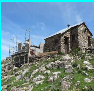
Les travaux de la cabane d'Espugues
