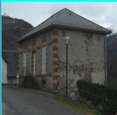
Nouvelle toiture du presbytere
