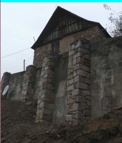
Les piliers de consolidation du mur d'Ayet
